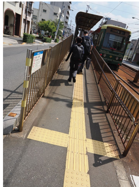
ホーム出口より2枚分誘導ブロック、横断歩道途中の部分（線路の手前）に警告ブロックを敷設している。【好事例】
