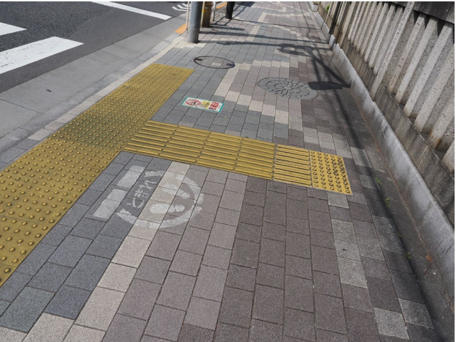
ホーム出口より2枚分誘導ブロック、横断歩道途中の部分（線路の手前）に警告ブロックを敷設している。【好事例】
