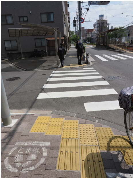
ホーム出口より2枚分誘導ブロック、横断歩道途中の部分（線路の手前）に警告ブロックを敷設している。【好事例】
